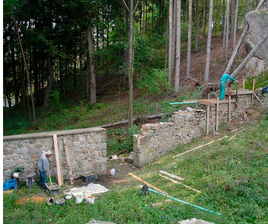
Židovský hřbitov v Úbočí - oprava hřbitovní zdi. Foto Václav Fred Chvátal.
